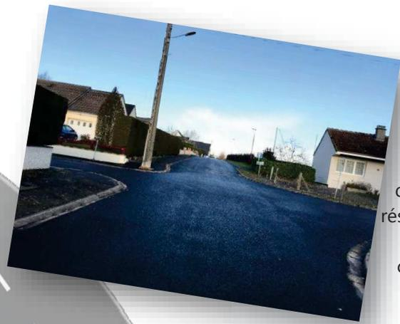
Des travaux d'effacement de réseaux aériens et la pose de candélabres ont été réalisés rue du Hameau Billard. Côté voirie, des travaux concernant le remplacement de caniveaux défectueux ainsi que le revêtement bitumeux ont été exécutés.
