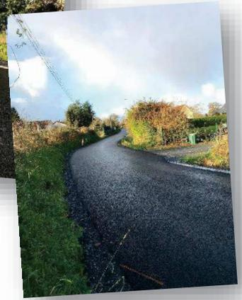
Après le renouvellement du réseau d'eau potable, rue de la Rairie, les travaux ont concerné la sécurisation des virages par la pose de trottoirs et le revêtement bitumeux. Il reste à réaliser l'étanchéité des emplacements des parkings et les délimitations.
