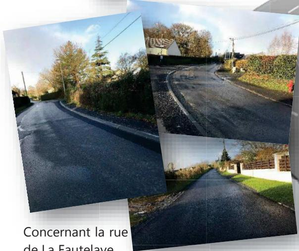
Concernant la rue de La Fautelaye, des travaux de renforcement de réseaux souterrains et aériens ainsi que l'extension du réseau gaz ont été accomplis. La sécurisation des virages afin de réduire la vitesse par la pose de trottoirs ainsi qu'une partie de la chaussée en revêtement bitumeux ont également été réalisés. Il reste l'étanchéité des trottoirs et les délimitations.
