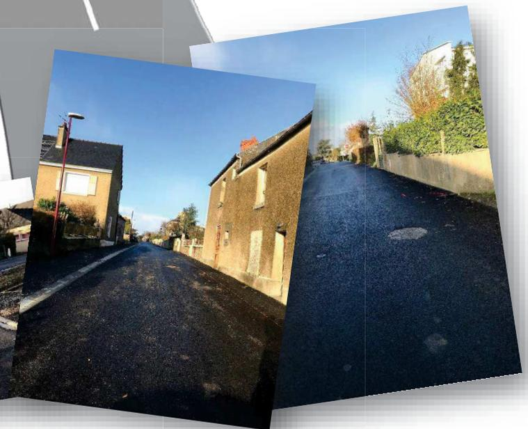
Les travaux les plus importants ont été réalisés rue de la Mairie avec l'effacement des réseaux aériens, le renouvellement des réseaux d'eau potable, d'assainissement et de pluvial, la pose caniveaux et revêtement bitumeux ainsi que la pose de candélabres. Il reste à réaliser l'étanchéité des trottoirs et les délimitations.
