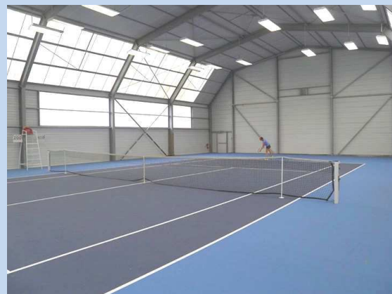
Nouveau revêtement du cours intérieur
